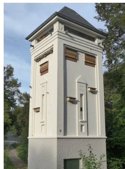
Hergerichteter Trafoturm „Elp“ Foto: AGNU Haan
