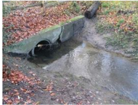
Naturferner Zustand des Rinderbachs
