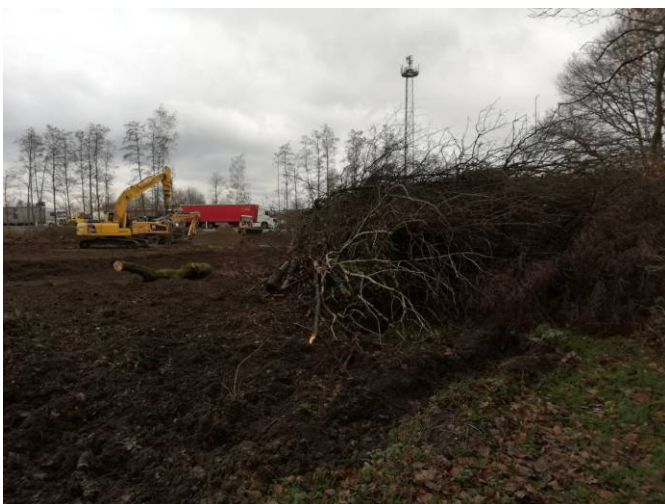
A3-Sanierung: Illegale Rodung
