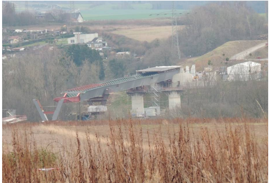
Anfänge der Angerbachtalbrücke
